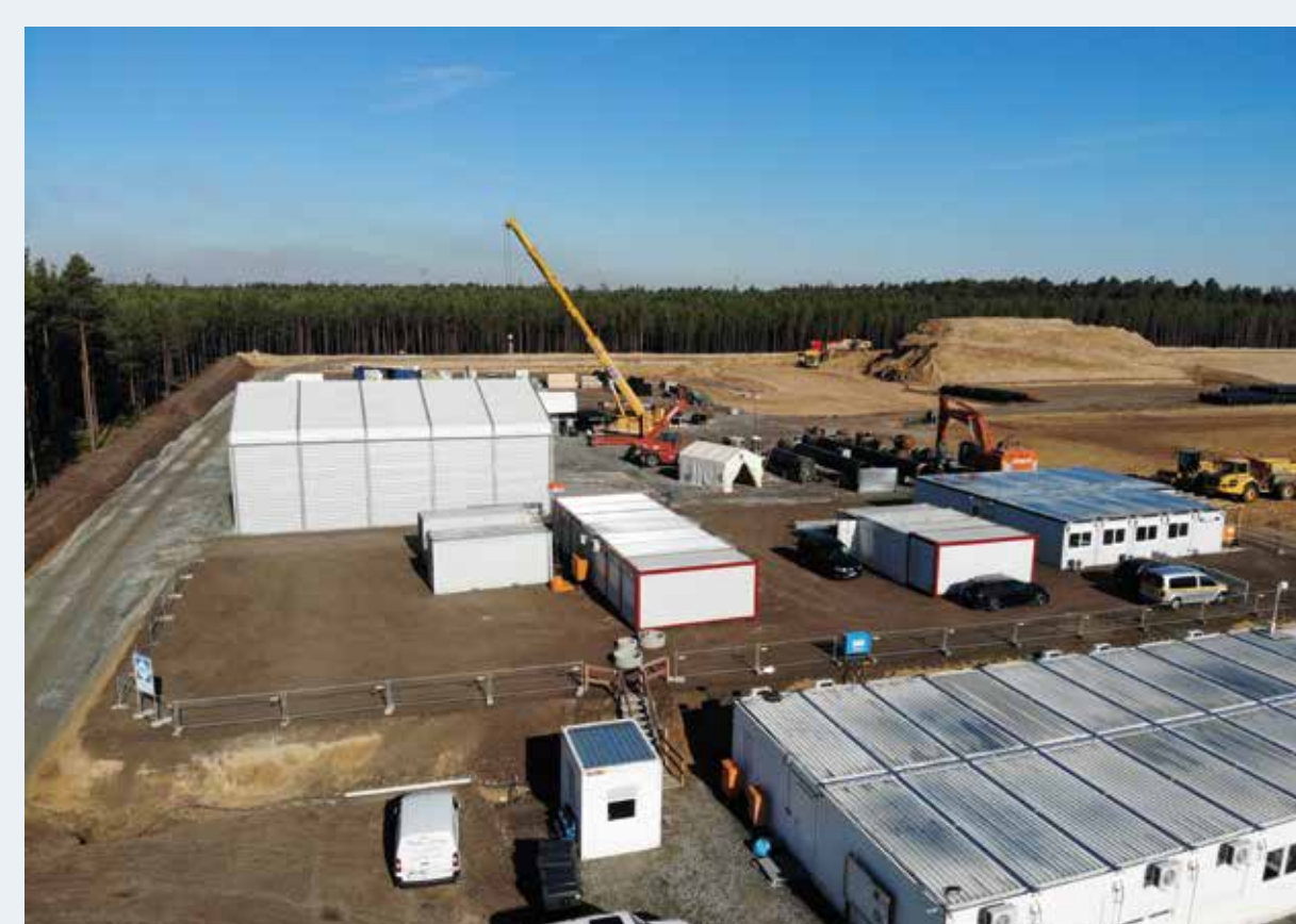
Beispiel Baustelleneinrichtungsfläche
