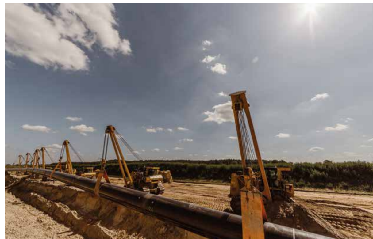
Antlieferung von Pipelinerohren per Bahn
