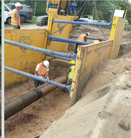
Bild 3: Alte Umhüllung wird händisch vom Leitungsrohr entfernt.
