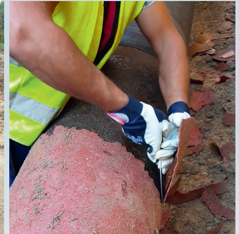
Bild 1: Leitungsrohr wird per Suchschachtung freigelegt.
